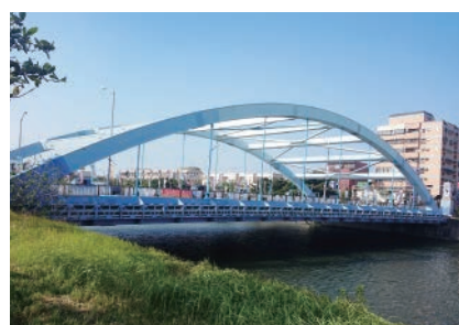
彰化鹿港福興橋 橋索更新工程
