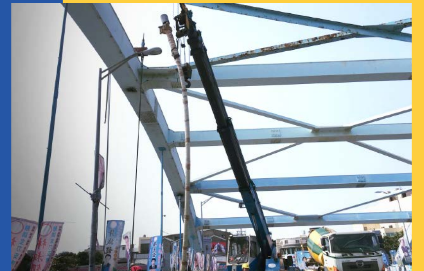
舊有橋梁橋索更新工程
