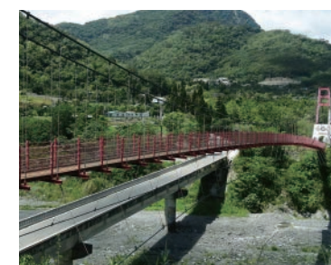
台東土坂吊橋檢測
