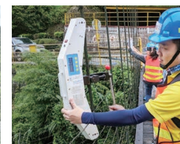
吊橋索力檢測
