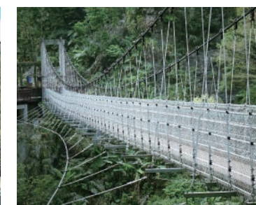
苗栗獅頭山神仙谷 吊橋整修工程
