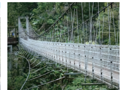
苗栗獅頭山神仙谷吊橋整修工程
