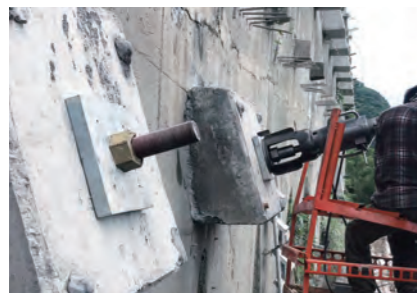
汐止水保工程地錨
