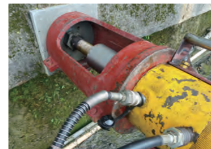
地錨複拉檢測
