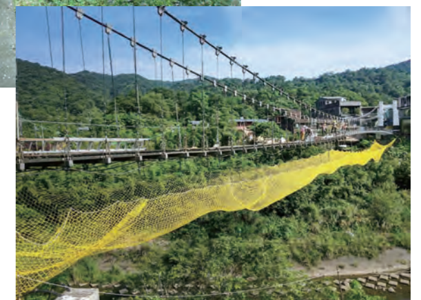
吊橋整修工程 平溪靜安吊橋
