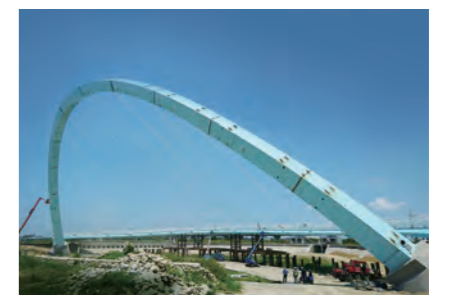
嘉義馬稠後產業園區 自行車景觀橋
