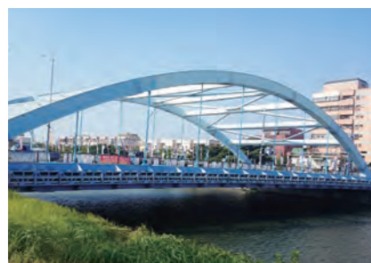
彰化鹿港福興橋 橋索更新工程
