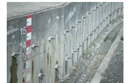
台南山上區地錨工程
