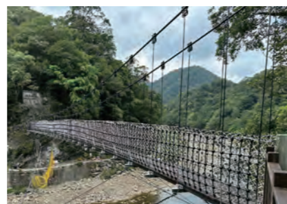
新北市坪林區闊瀨吊橋
