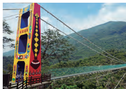
高雄多納高吊橋
