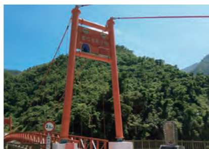
台東金崙魯拉克斯吊橋
