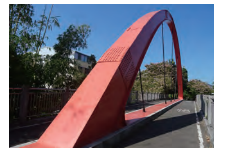
台中東豐自行車綠廊11K 虹橋換索工程
