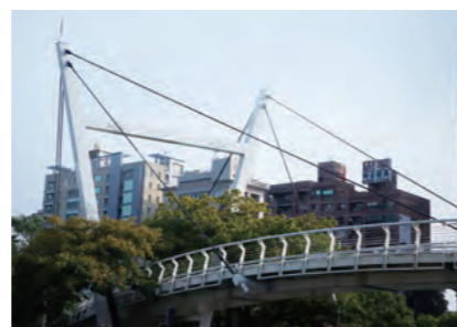
高雄愛河之心人行橋 換索工程
