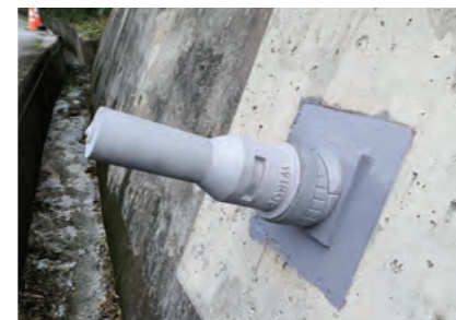
台9戊邊坡地錨
