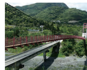
台東土坂吊橋維護工程
