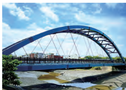
新竹17公里海岸線 虎山橋換索工程
