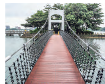
高雄澄清湖富國島吊橋
