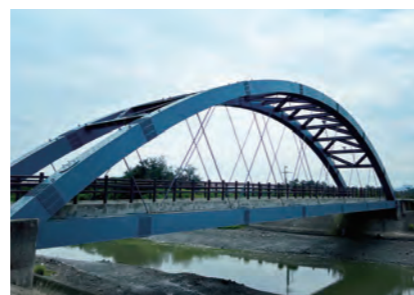
新竹17公里海岸線 海埔橋換索工程
