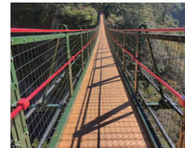
南投奧萬大吊橋維修工程
