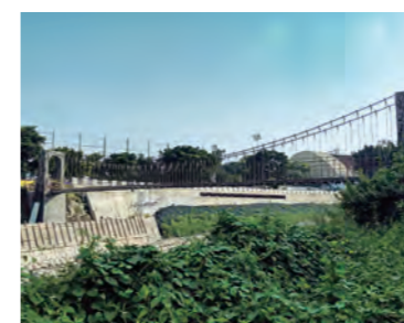
台南鳳凰吊橋
