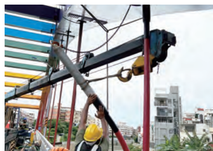
新竹印順橋 橋索更換工程
